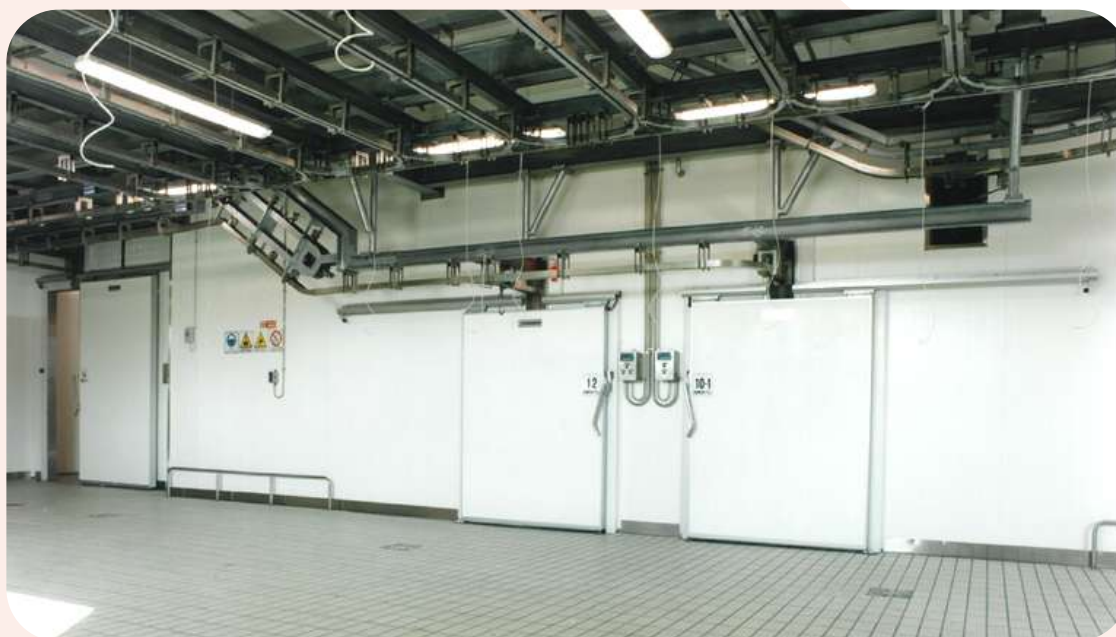
PORTA SCORREVOLE CON GUIDOVIA A "GUIDA INTERROTTA"
